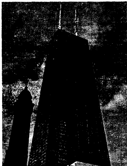
17.8-rasm. Baland bino tashqi bog'lovchi fermalar bilan.
