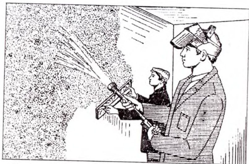
6.1- rasm. Qorishmani mexanizatsiyalashgan holda suvash.
