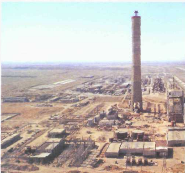
Тадмиржон иссиқлик электр станцияси.
