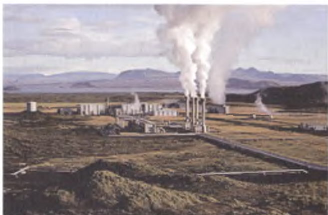
19-rasm. Dunyodagi eng katta geotermal elektrostansiyaning ko'rinishi.
