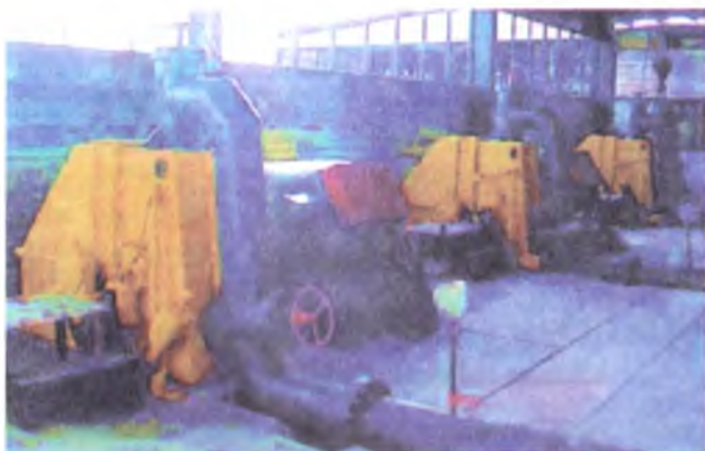
46-rasm. Vertikal o'rnatilgan cho'michli ish g'ildirakli kichik GES mashina zalining ko'rinishi.
