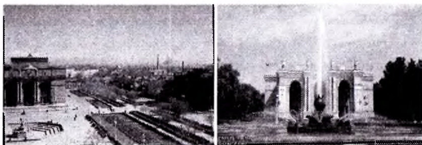
42-rasm. Alisher Navoiy opera va balet teatri eski va yangi holati
