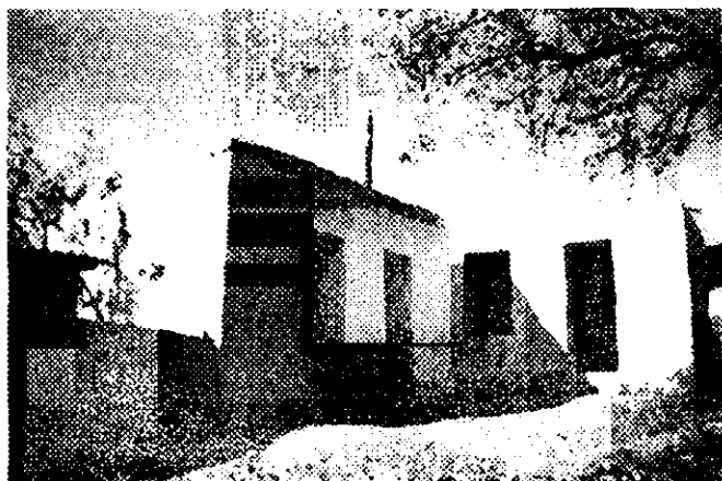
69-rasm. Chapda tom yopmasi yog'och to'sinli, ichki temirbeton o'zakti monolit gil devor konstruksiyali eksperimental bino.
