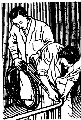
64- расм. Зинапоя тутқичларини кўчма инфрақизил нурланиш аппаратлари ёрдамида қиздириб туриб ўрнатиш.
