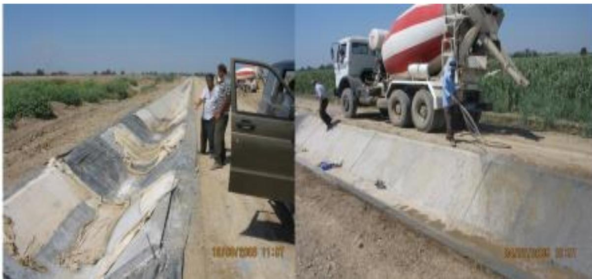
3.10 - расм. Қўйилган бетонга техник қаров ишларини амалга ошириш
